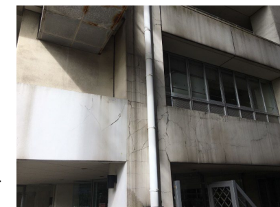
外壁の剥落・落下
