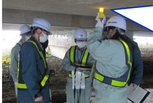
(主) 盛岡和賀線太田高架橋の点検状況 (電子顕微鏡を用いた高精度ひびわれ計測システム)
