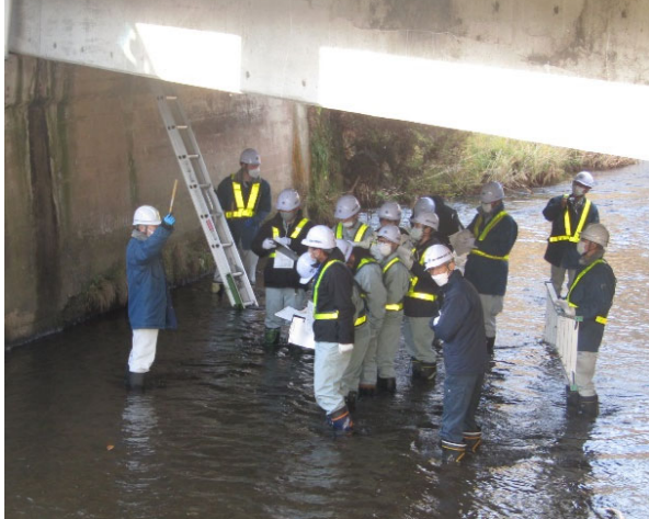
(一) 渋民川又線旗井沢橋の点検状況
