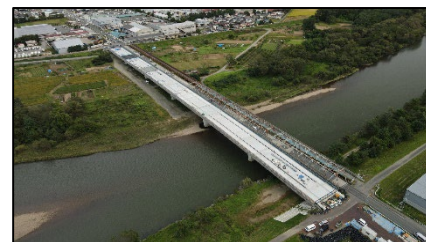
地域連携道路整備事業（徳田橋）
