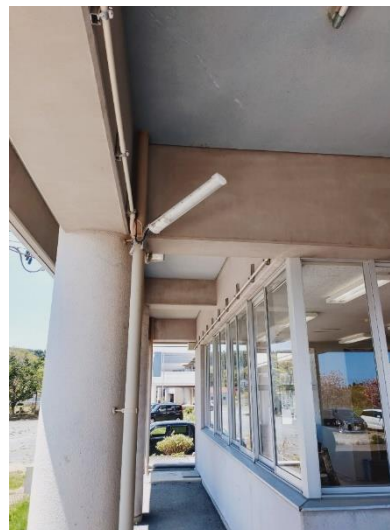
【にぎわい創造交流施設「ヒロノット」へ設置した様子】
