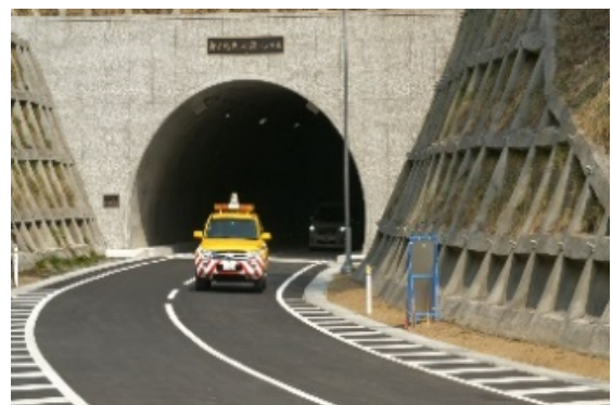
【整備後の新県道の状況】
