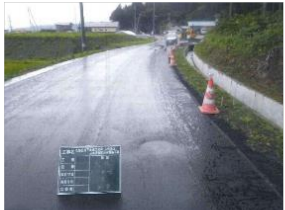
【D-21-1 工事写真】 (完 成 後)
