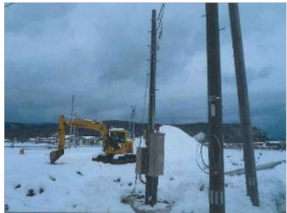
【D-21-1 マンホールポンプ工事写真】 (完 成 後)
