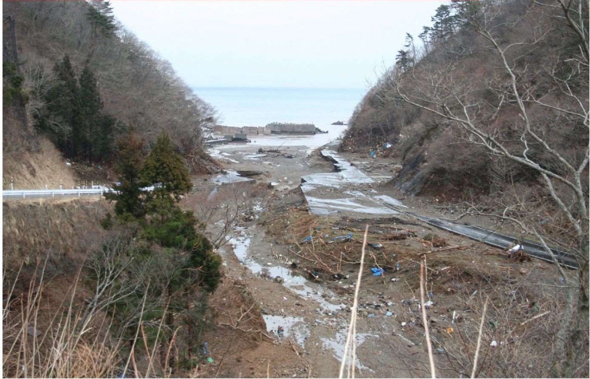
津波により通行止めとなった主要地方道県道岩泉平井賀普代線(机地区)
