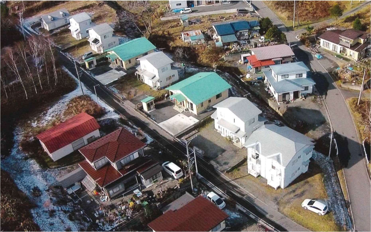
【完成写真（緑色屋根の建物2棟）】
