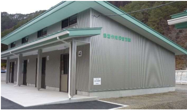
島越作業保管施設 A 棟
