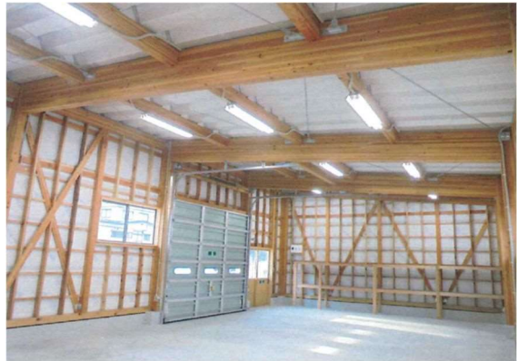
上川原作業保管施設内観
