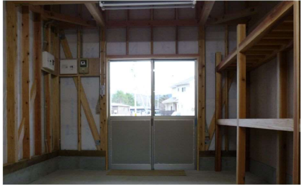
拓洋台作業保管施設内観
