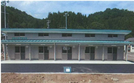
羅賀作業保管施設 A 棟
