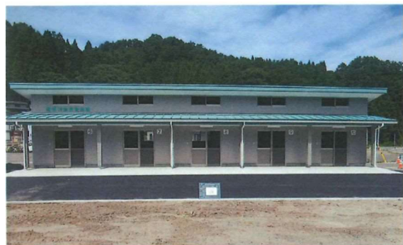
羅賀作業保管施設 B 棟
