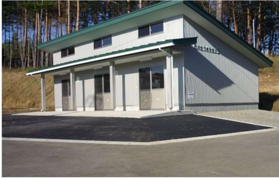
拓洋台作業保管施設
