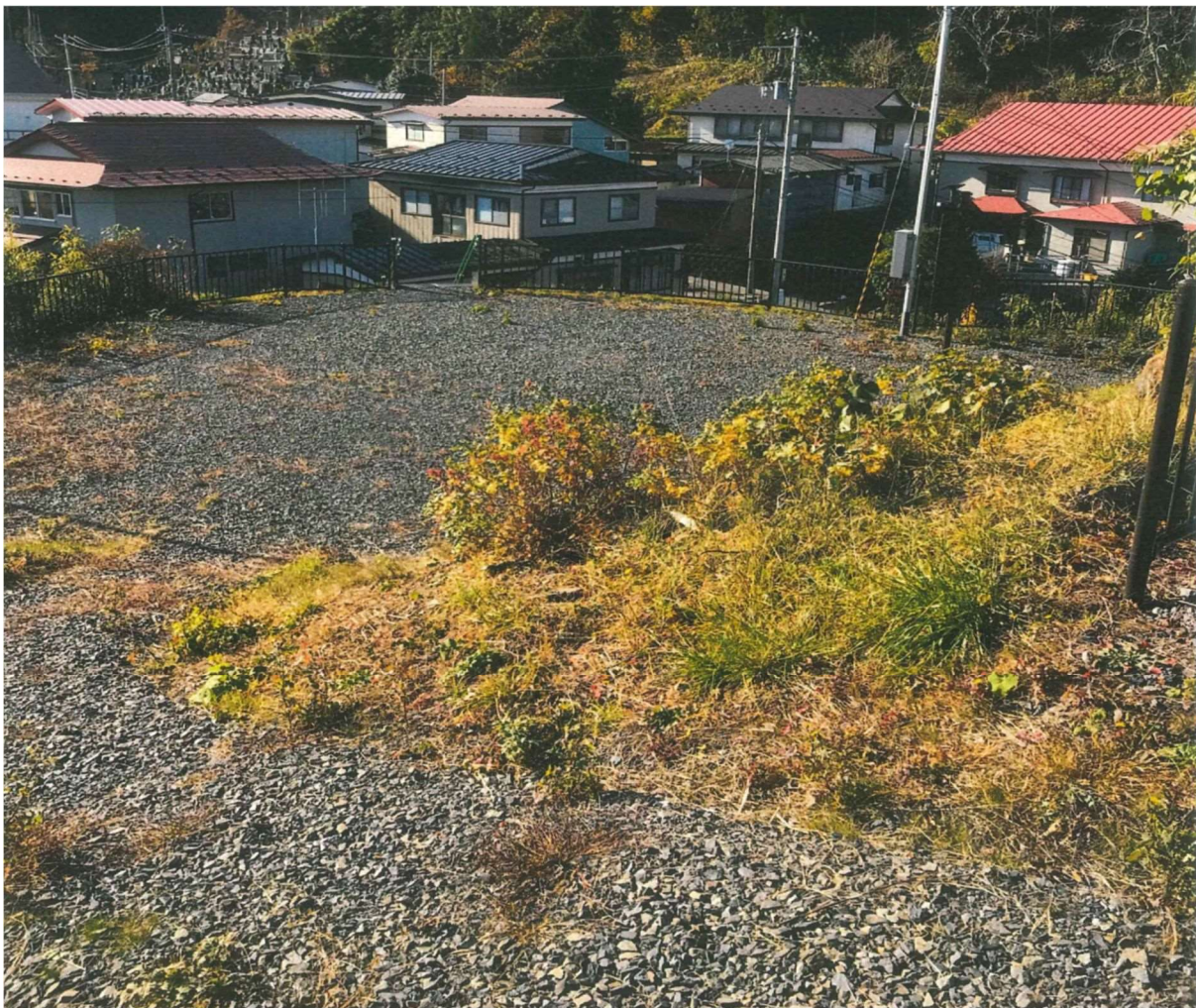
【島越地区避難路等整備 完成写真】
