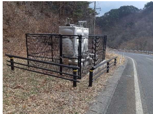
【位置② 2号減圧水槽】
