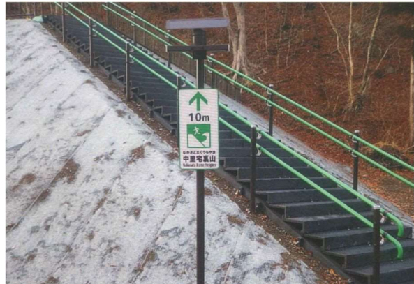
避難誘導標識
