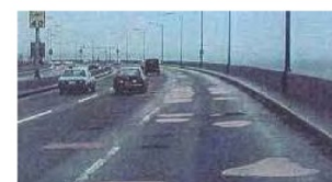
【有料橋の床版補修】
