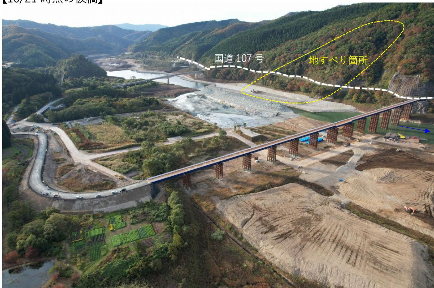
錦秋湖を横断する仮橋の鋼管杭打ち込みと桁架設は、クレーンに乗せた台船をダム湖面に浮かべて行うため、ダム水位の調整が必要です。ダム管理者である国土交通省北上川ダム統合管理事務所をはじめ、利水者である県企業局・東北自然エネルギー(株)・岩手中部土地改良区の皆様には水位調整にご協力いただき無事に施工することが出来ました。この紙面をお借りして御礼申し上げます。
