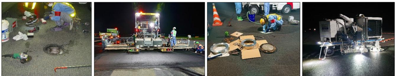
(航空灯火撤去工) ⇒ (アスファルト舗装工) ⇒ (航空灯火設置工) ⇒ (グルーピング工)
