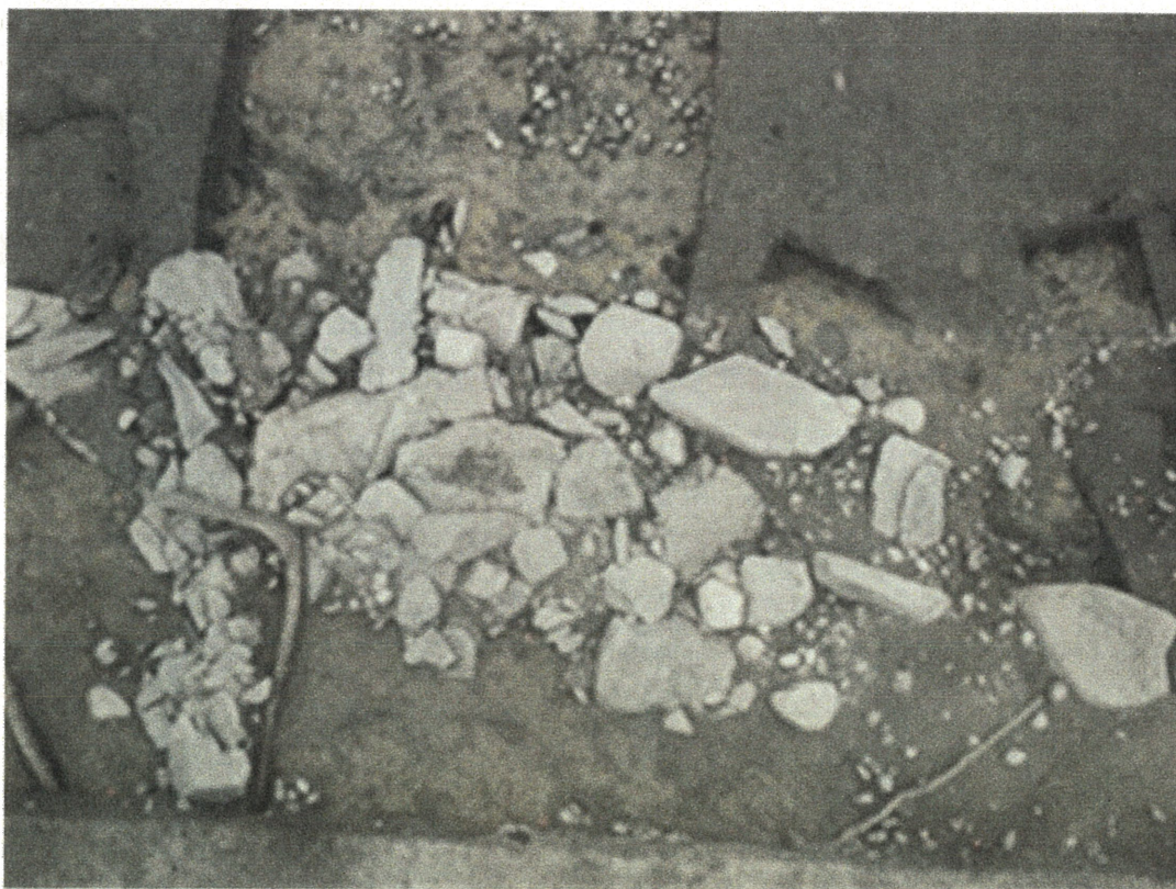
写真4 東島北岸護岸石検出状況 (北西から南東方向)
