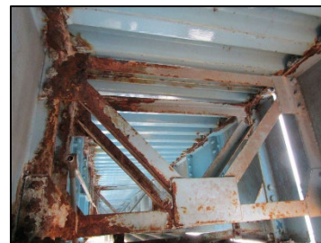
【損傷した橋げたの補修】 国道284号上の橋（一関市）
