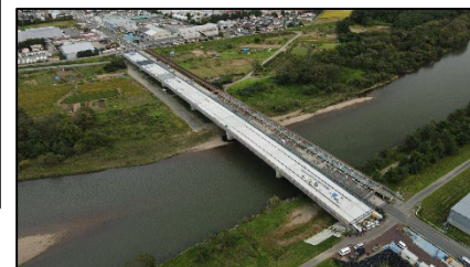
地域連携道路整備事業（徳田橋）
