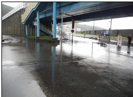
国道106号冠水状況(R3.9.15)
