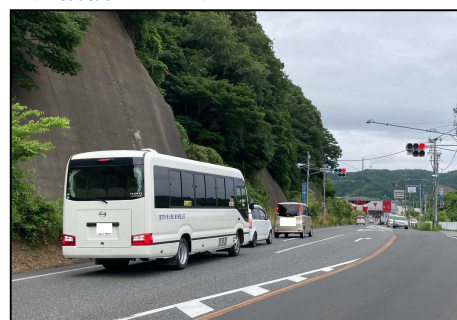
整備後 (交通渋滞緩和状況 : R4.6月撮影)
