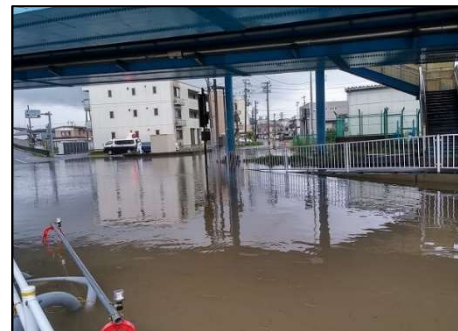
国道106号冠水状況(R2.9.23)
