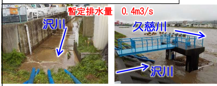
<本川合流部への仮設ポンプ設置状況>
