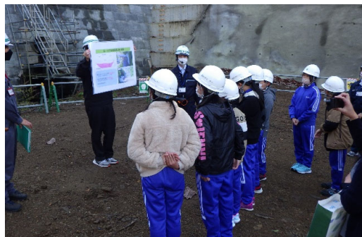
砂防堰堤の工事現場見学
