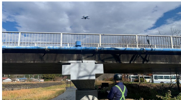
主要地方道 岩泉平井賀普代線 新普代橋（普代村）
