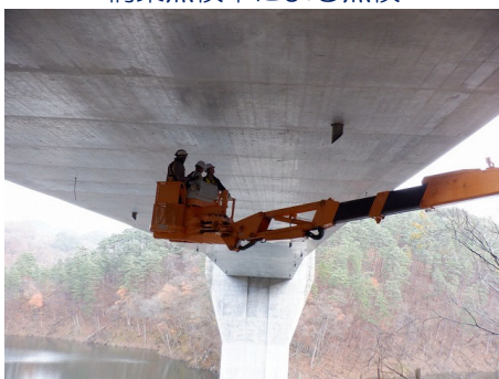
国道106号 築川大橋（盛岡市）
