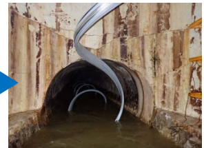
② 更生管投入
