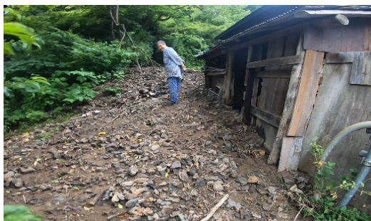
被害状況：国境の沢（8）（岩泉町）
