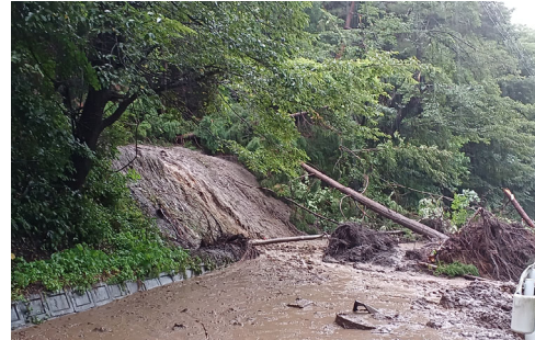
一般県道姉帯戸田線の被害状況（一戸町）
