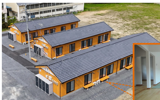
応急仮設住宅の整備状況（旧蛸ノ浦小学校）
