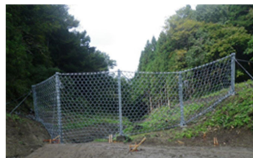
緊急対策完了状況：小安孫沢（葛巻町）
