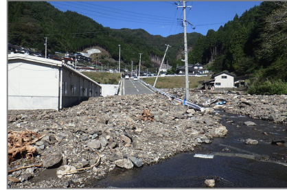
土石流の発生（釜石市）
