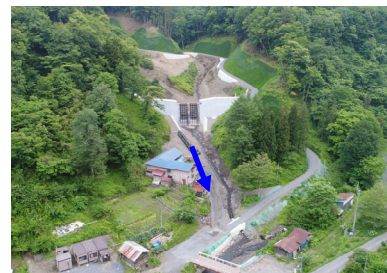
砂防堰堤完成状況：大沢（6）（岩泉町）
