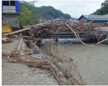
小本川流域の被害状況（岩泉町）
