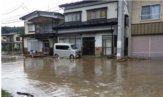
一戸町内の被害状況
