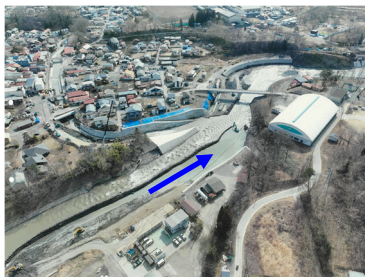
小本川 市街地区 施工状況（岩泉町）
