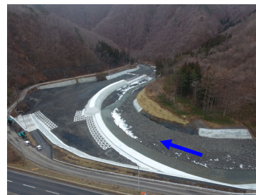
小本川 流木捕捉工 完成（岩泉町）
