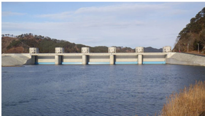
鵜住居川水門の閉鎖状況（釜石市）
