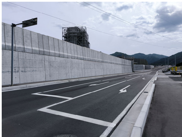
令和5年度完成 普金地区海岸（大船渡市）
