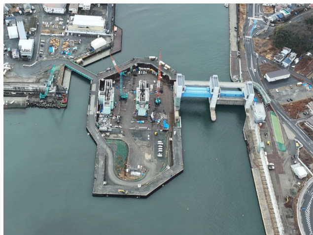
令和8年度完成予定 閉伊川水門（宮古市）
