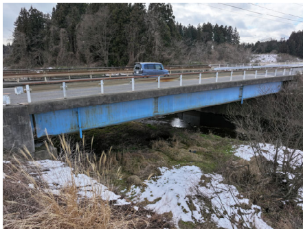
主桁 塗替塗装前
