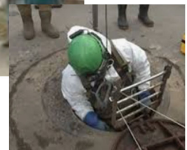
市町村向けの法定施設点検見学会
