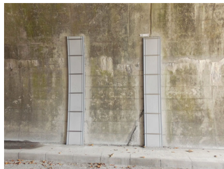
導水樋 取替後
