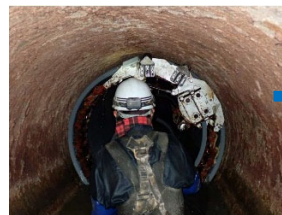
③ 更生管設置
