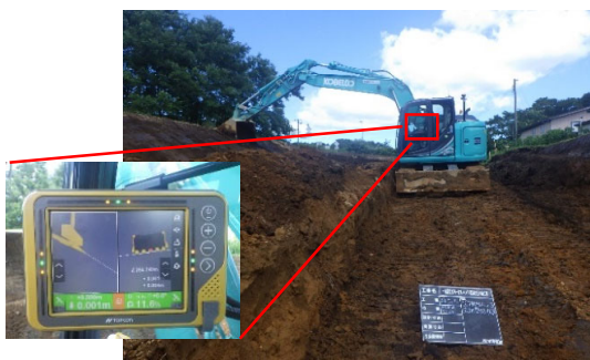
I C T建設機械による施工状況
