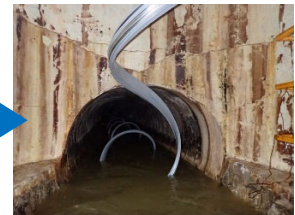
② 更生管投入
