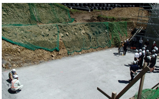
吉里吉里の沢(3)砂防堰堤での測量体験
