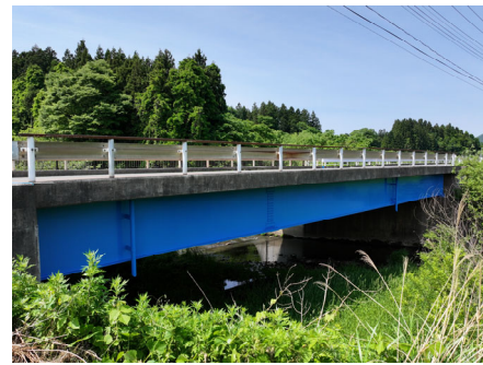
主桁 塗替塗装後
