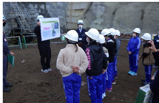
砂防堰堤の工事現場見学
