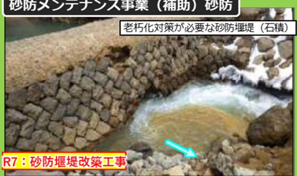
老朽化対策が必要な砂防堰堤（石積）
