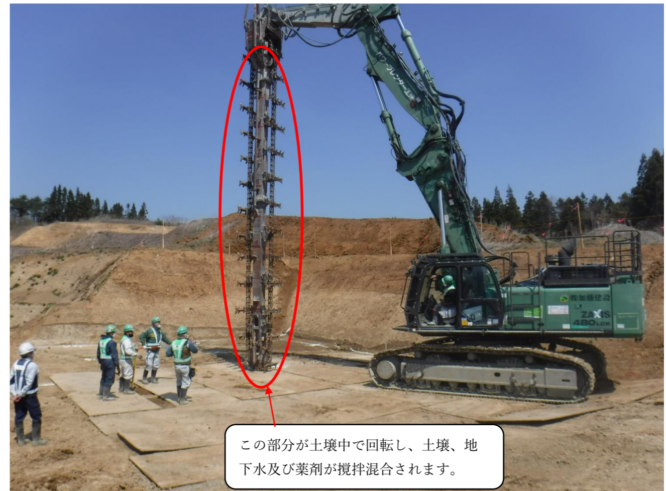
写真2 パワーブレンダー工法で使用する重機
