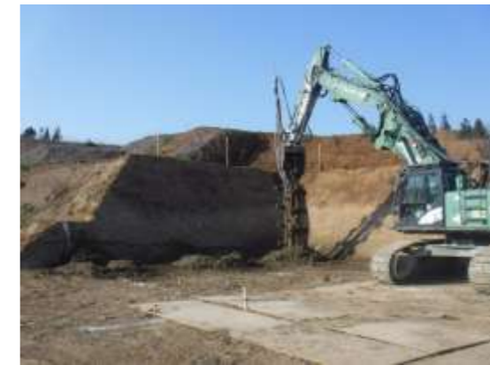
図3 H30D-3（R3年度薬剤注入工未施工）における施工深度確認の様子
