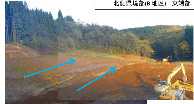
北側県境部(B地区) 東端部
