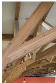
柱と梁の間に加える種強のための部材を建築では「方杖（ほうづえ）」と呼ぶ。この方杖には、町産材であるスギでつくられた集成材を用いた
