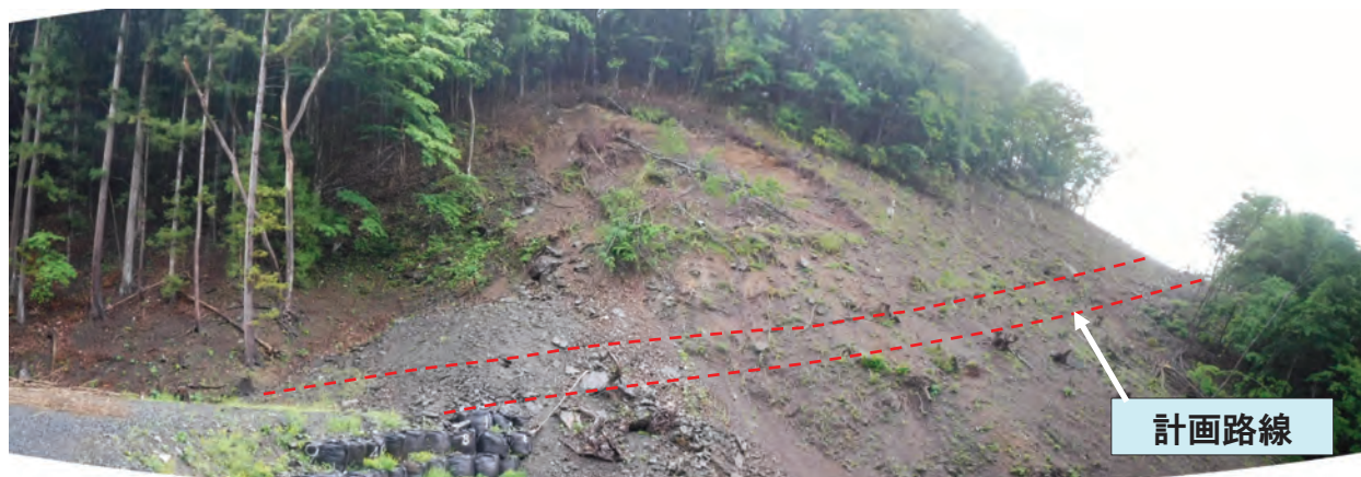
法面崩壊復旧対策工事を行う現場の状況
