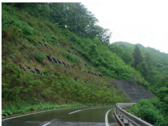
法面保護工の実施 (地すべり対策実施箇所)
