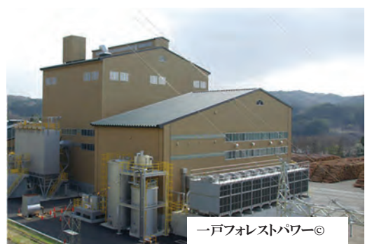
木質バイオマス発電所
