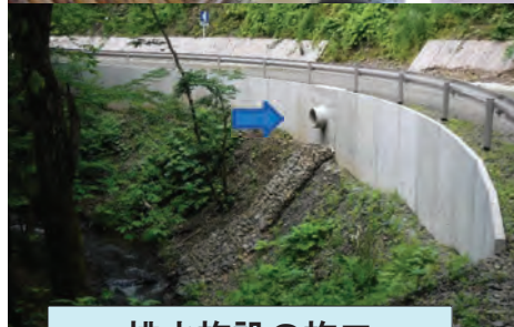
排水施設の施工
