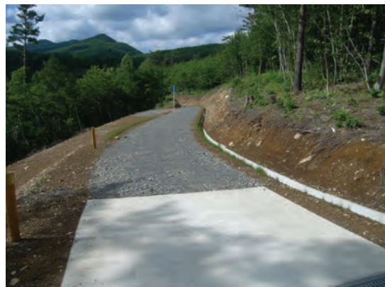
視線誘導標での施工
