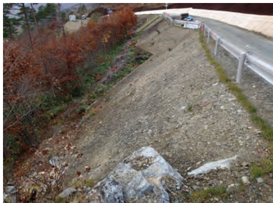
防護柵での施工
