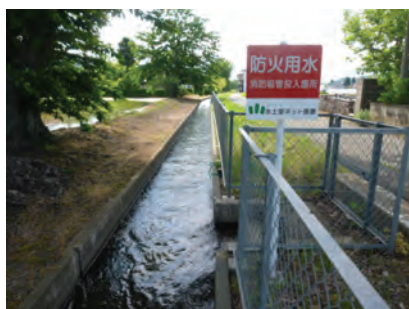
写真左: 防火施設
