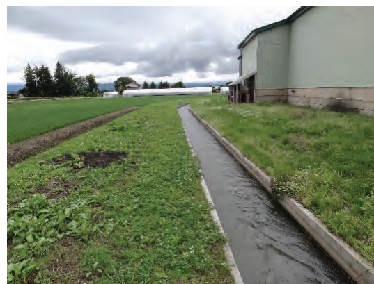
写真右:水路工(改修後)
