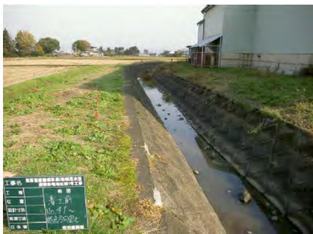
水路工(改修前)
