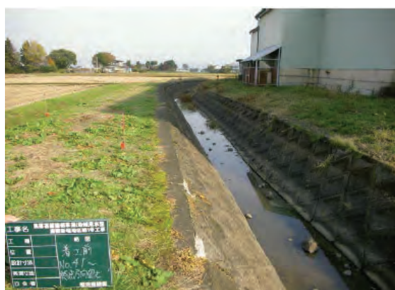
写真左:水路工(改修前)
