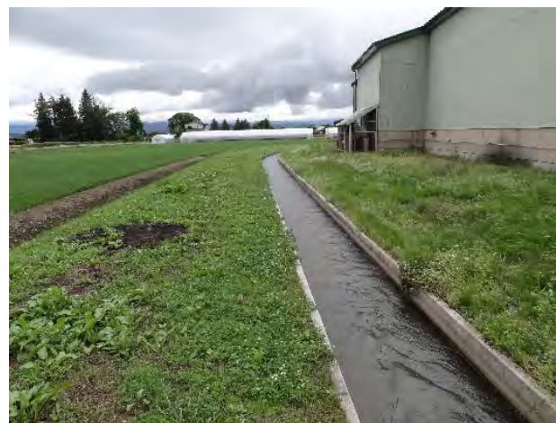
水路工(改修後)
