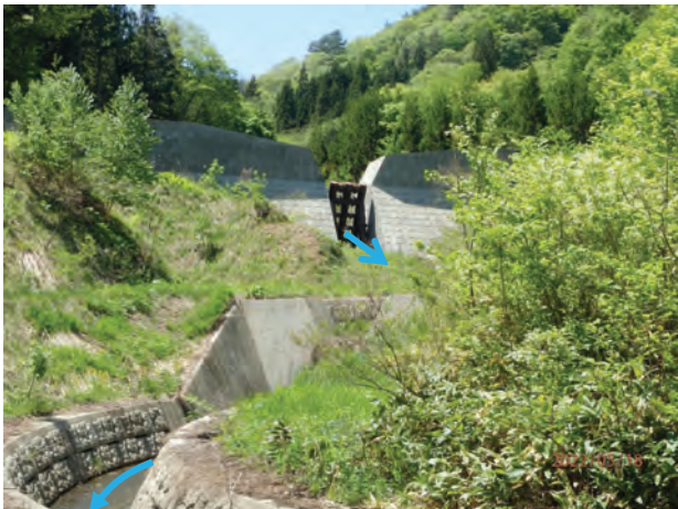
完成砂防堰堤 (R4年5月撮影)
