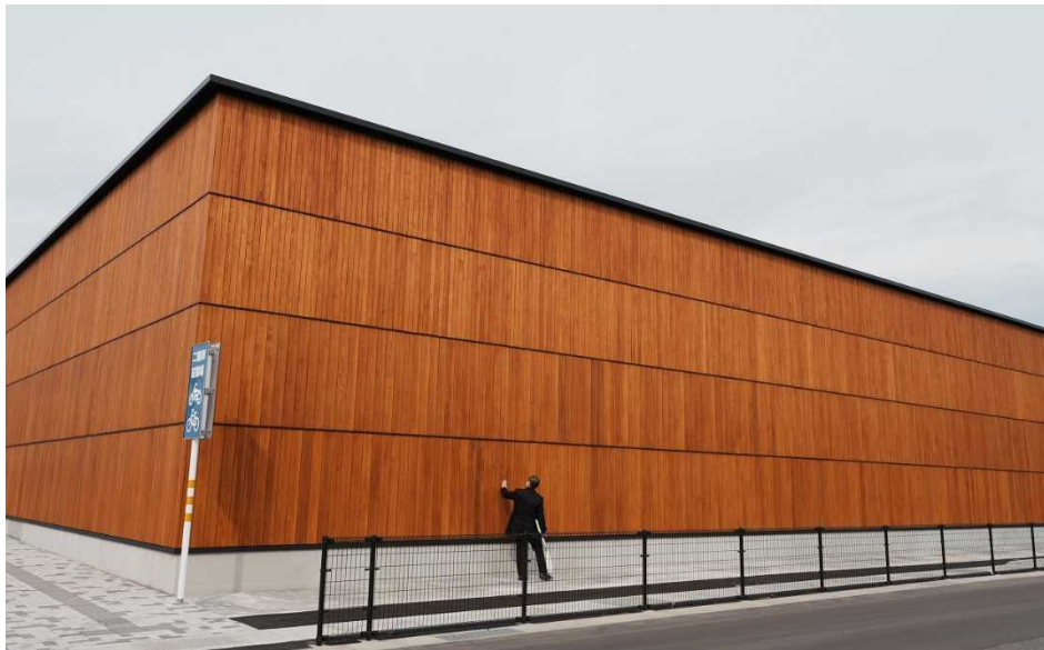
■店舗の外装木質化（㈲橋市土地開発 [無印良品矢巾]）
