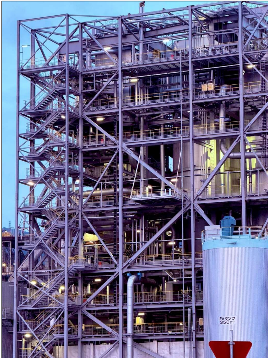
道路から見えるセメント工場の施設
