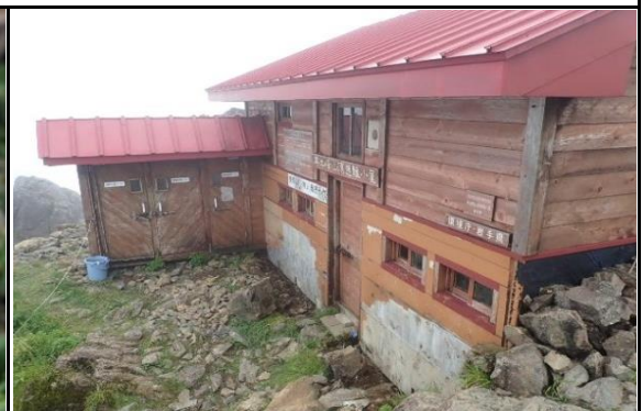
改築工事が始まっていた山頂避難小屋
