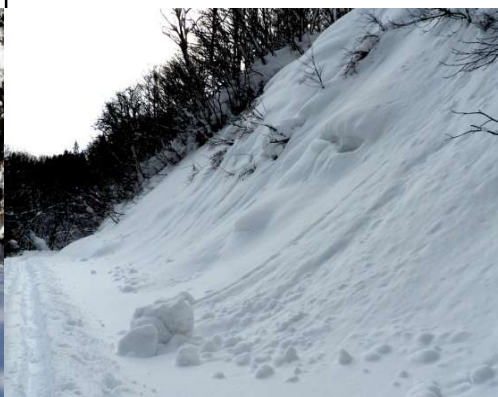
例年雪崩れが発生する箇所
