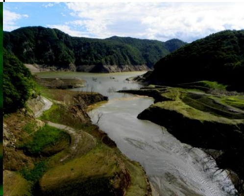
水位の下がった胆沢ダム
