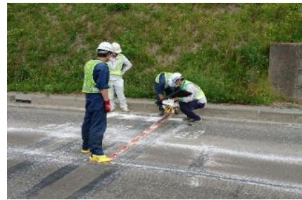
【研修中】現場での出来形計測実習
