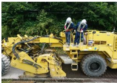
【研修中】現場での機械操作実習
