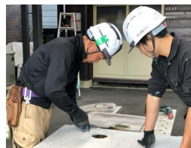
大工工事の様子
