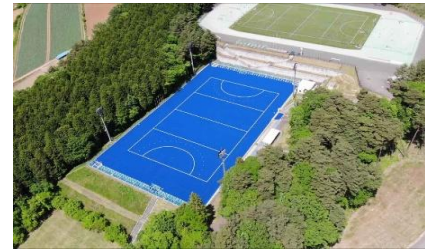
岩手町サッカー場人工芝敷設工事
