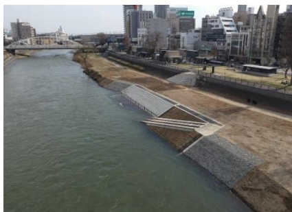
河川維持工事(盛岡駅前地区船着場)
