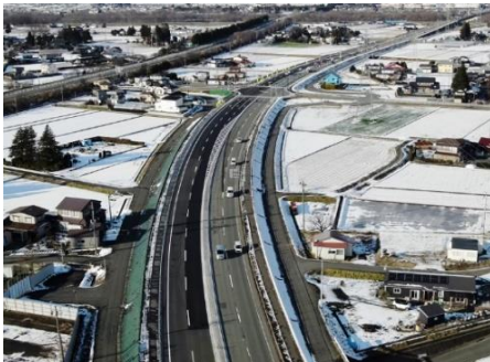
改良舗装工事（国道46号4車線化）
