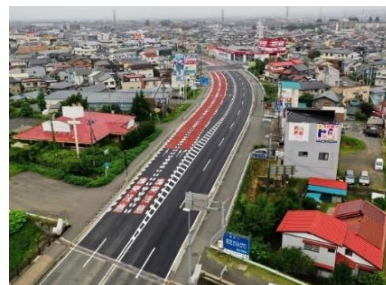
国道維持補修工事(国道4号舗装修繕)
