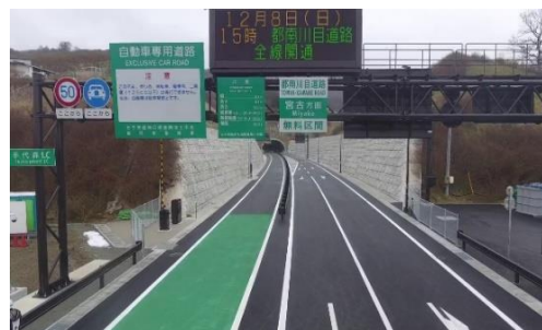
手代森地区付属施設設置工事
