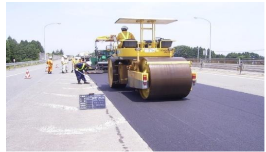
高速道路NEXCO東日本舗装工事
