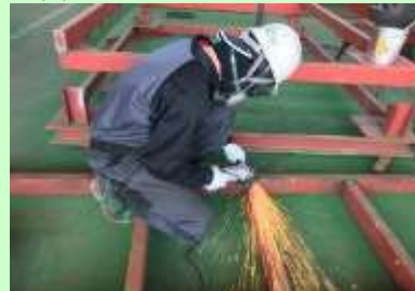
サンダー(溶接後の研磨作業)をかけているところ
