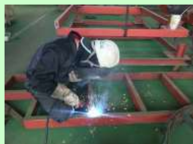
溶接作業をしているところ
