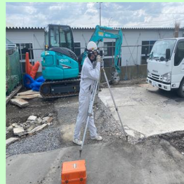
▲測量をしているところ
