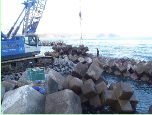
▲津波で流失した消波ブロックの据え付け工事 (野田村)
