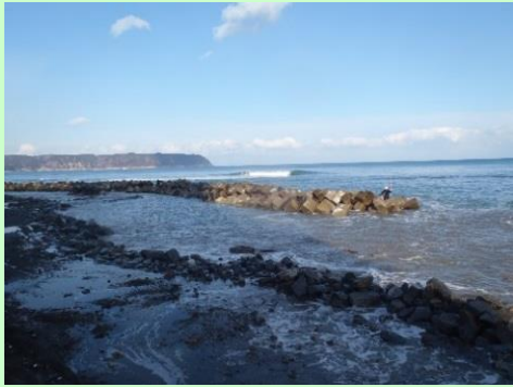
▲改修が終わった消波堤 (野田村)
