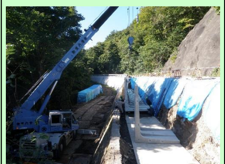
▲L型擁壁設置工事 (擁壁とは斜面が崩れない様にする土留めのこと)
