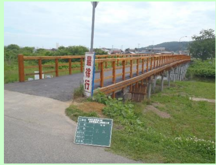
▲木製の欄干も新しくなった新街橋
