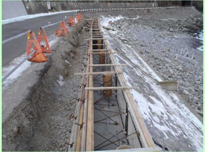
▲津波で損壊したガードレールの改修工事 (小袖海岸)
