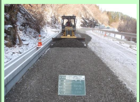
▲アスファルトの下に敷く砕石のならし工事
