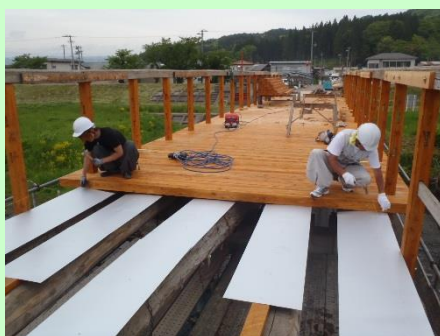
▲橋の路面となる床板の取付工事
