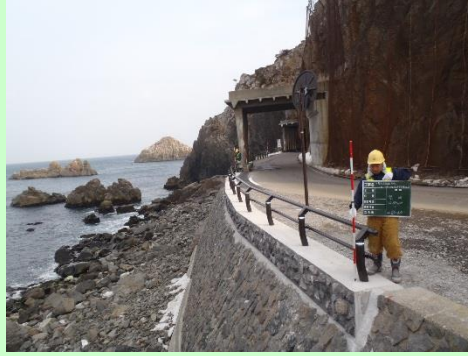
▲ガードレールの改修工事により路幅も広めとなった (小袖海岸)
