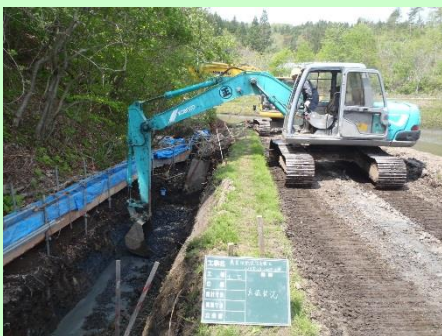
▲コンクリートブロックを載せる基礎部分の掘削工事
