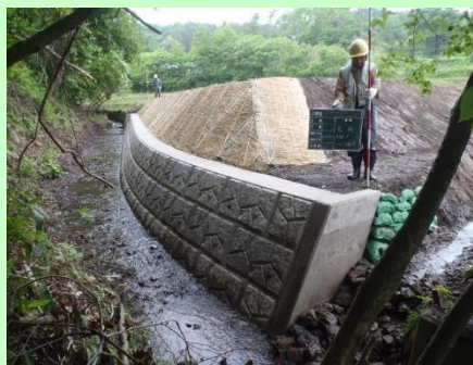
▲土留めをする擁壁が完成した様子
