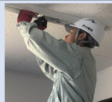
【電気の配線作業】
