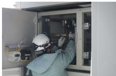
▲非常用発電機へのケーブル接続 状況を確認している作業
