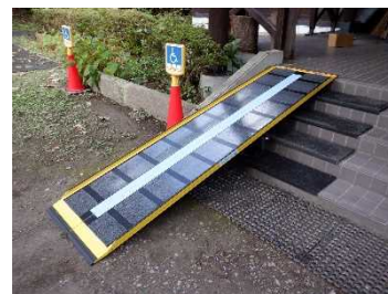
車いす用スロープ設置
