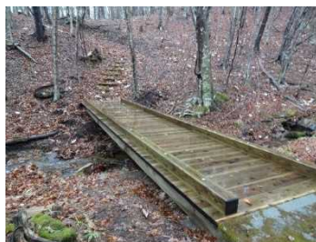
遊歩道整備（木橋）
