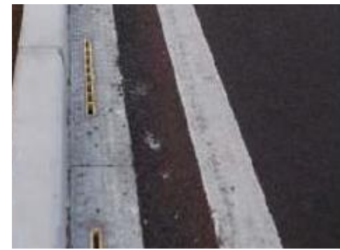
(整備後)暗渠側溝(イメージ)
