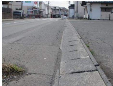
(現況)落蓋式側溝
