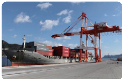
釜石港 ガントリークレーン
