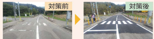
(主)上米内湯沢線 米内小学校前(盛岡市) 車止めの設置
