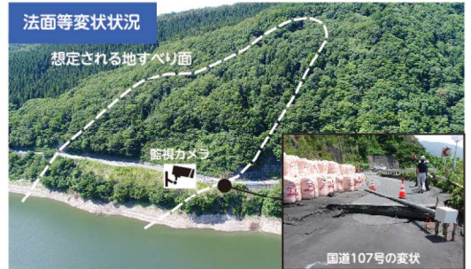
秋田自動車道に並行する国道107号で発生した地すべり (令和3年5月)
