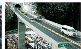
三陸縦貫自動車道(釜石山田道路) H23.3.5開通
