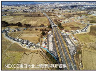
NEXCO東日本北上管理事務所提供 東北自動車道 花巻PAスマートIC(花巻市) 令和6年3月開通
