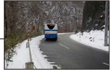
国道281号 案内～戸呂町口(久慈市) 令和2年度事業化(災害リスクや線形不良の解消)
