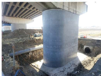
(主)一関北上線 中里橋(一関市)
