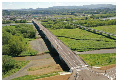
一般国道397号 新小谷木橋(奥州市) (令和3年5月31日開通)
