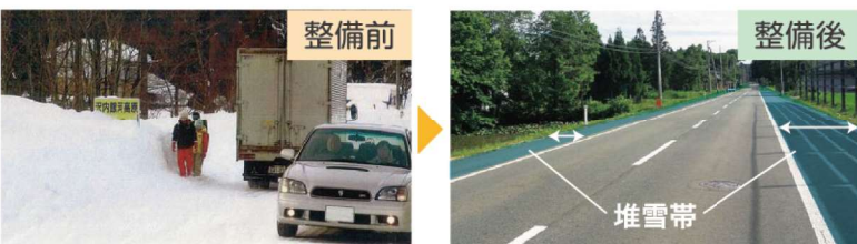
(主)盛岡横手線(西和賀町)の堆雪帯整備
