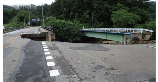
箱石連骨部道路に並行する国道106号で発生した道路流出 (平成28年8月 台風第10号)
