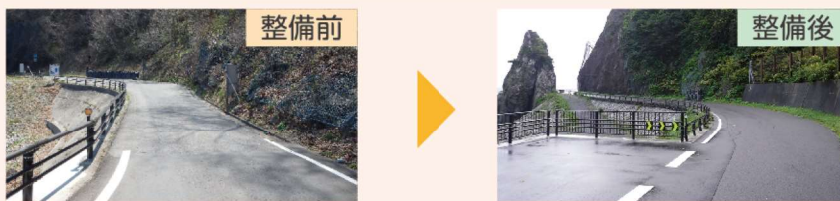
(一)野田長内線 小袖~大尻工区(久慈市)
