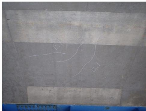
床版に1方向で幅0.1mm程度の床版ひびわれが確認される。ひびわれ間隔は300mm程度である。
