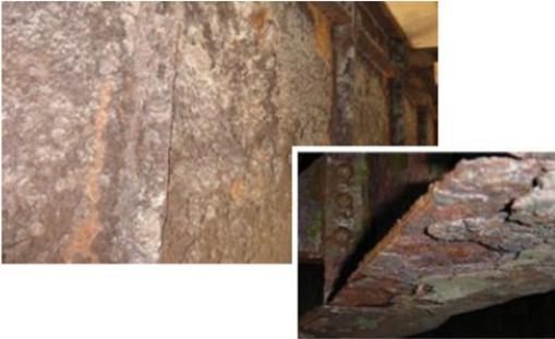
鋼主桁に著しい腐食が広範囲に見られ、一部で著しい板厚減少が確認される。設計断面が不足しており、耐荷力が著しく低下している。
