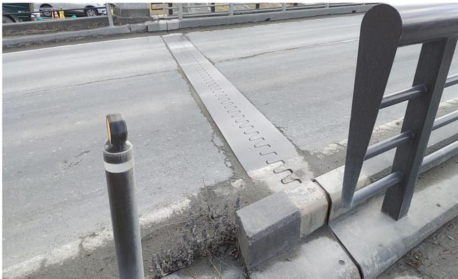
○工事状況(伸縮装置交換工)
