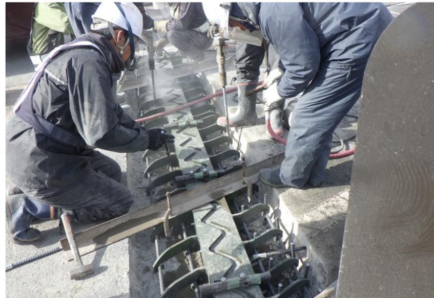
○工事完成(伸縮装置交換工)
