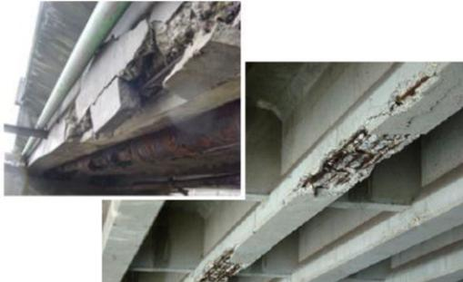
コンクリート桁（PC桁）に広範囲な鉄筋露出が確認される。設計断面が不足しており、耐荷力が著しく低下している。
