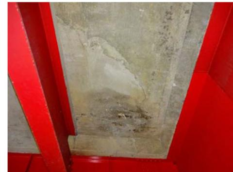
床版下面に、遊離石灰の析出が確認される。橋面水の浸透によるひびわれ面の擦り磨きを助長することが懸念される。
