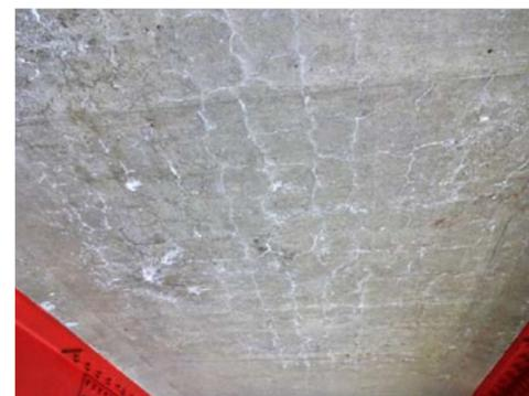
RC床版下面に漏水・遊離石灰を伴う2方向の床版ひびわれが確認され、一部に角落ちも確認されるため、床版の連続性に影響が生じている可能性がある。
