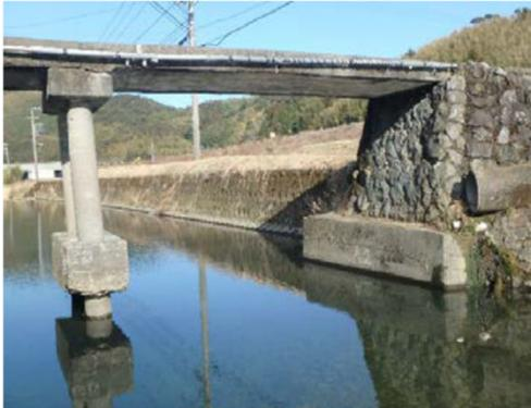
洗堀の影響により、橋脚が沈下・傾斜しており、通行ができない状態である。
