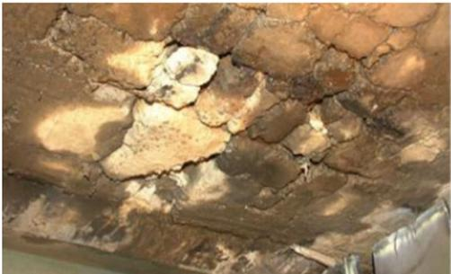
RC床版に床版ひびわれの進展により床版の一体性が消失している。
