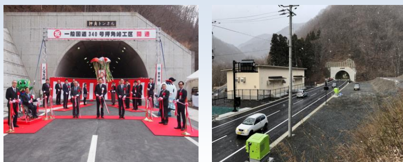
【復興支援道路】国道 340 号 押角峠工区 開通（令和2年12月）
