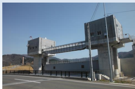
令和 2 年度に完成した須崎川水門（大船渡市）
