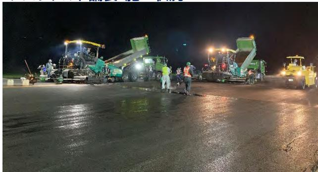
7 月末時点で航空灯火撤去、および滑走路本線のアスファルト舗装工が完了しました。
