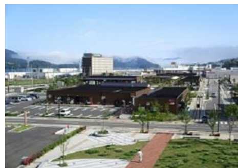
【津波防災拠点市街地形成施設】（大船渡市）
